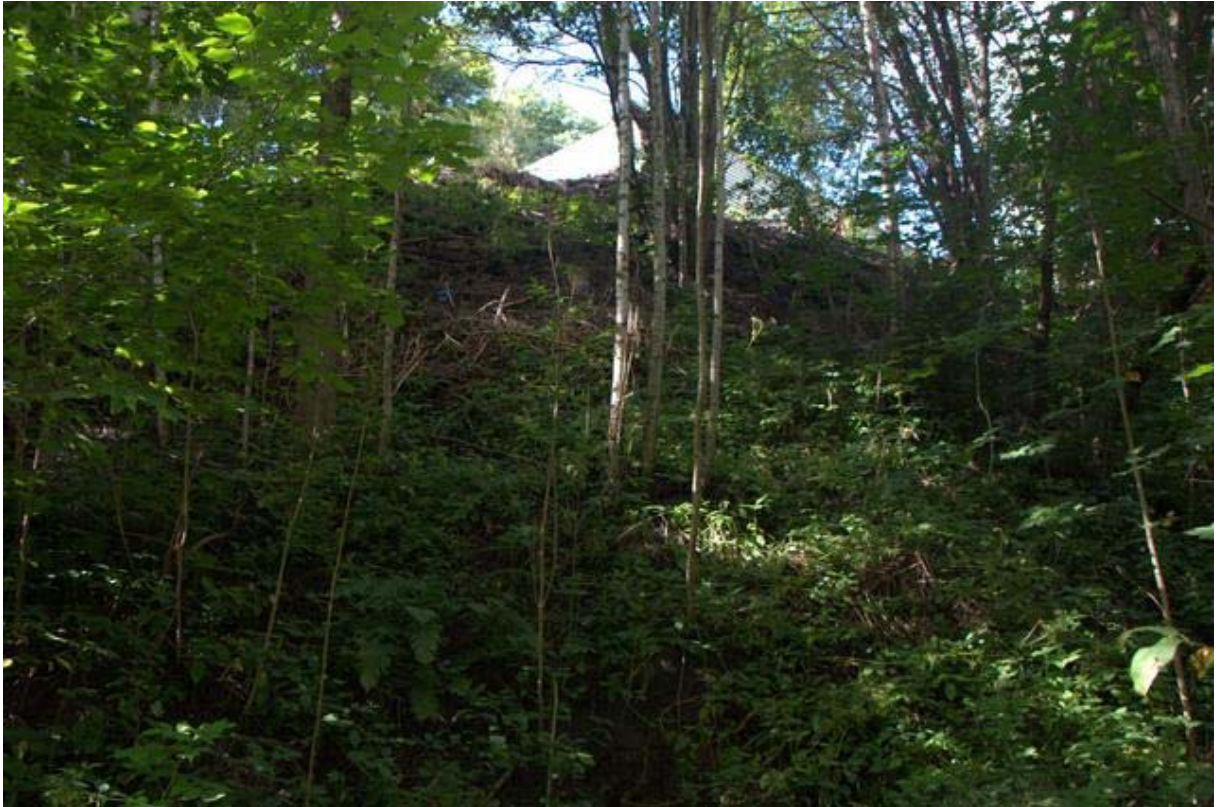
Figur 1 Slagghaugen sett fra nedsiden. Ferroniob produksjonen foregikk i bygningen i bakgrunnen. Denne rommer i dag AS Ulefoss Mekaniske.
